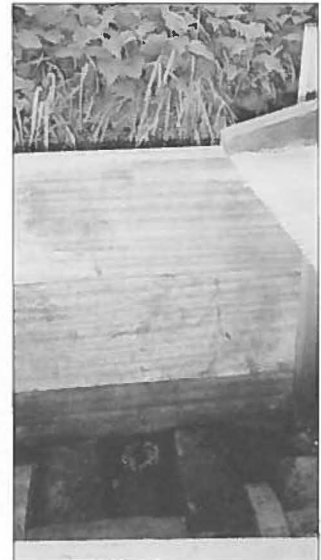
Begin van de dreineerbuis naar het winterverblijf
